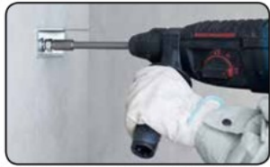
⑤ 挿入 (専用マシンホルダー使用)
