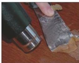
페인트 제거 Removing Paint
